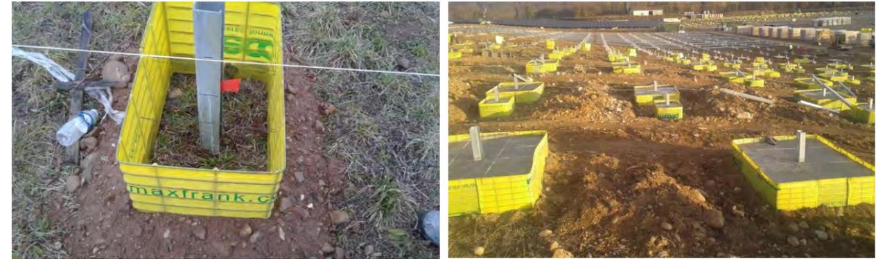
Figure 171 : Descriptif de la mise en place des longrines en béton
