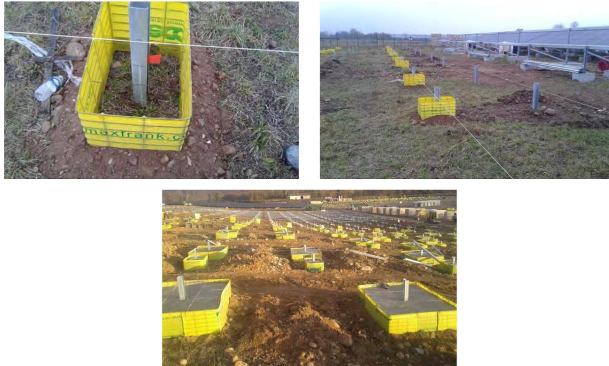
Figure 167 : Installation des longrines béton (Source : ADIWATT)
