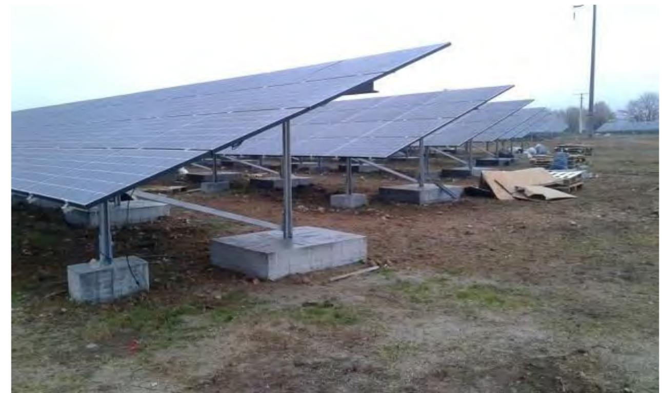
Figure 168 : Les panneaux posés sur longrines béton (Source : ADIWATT)
